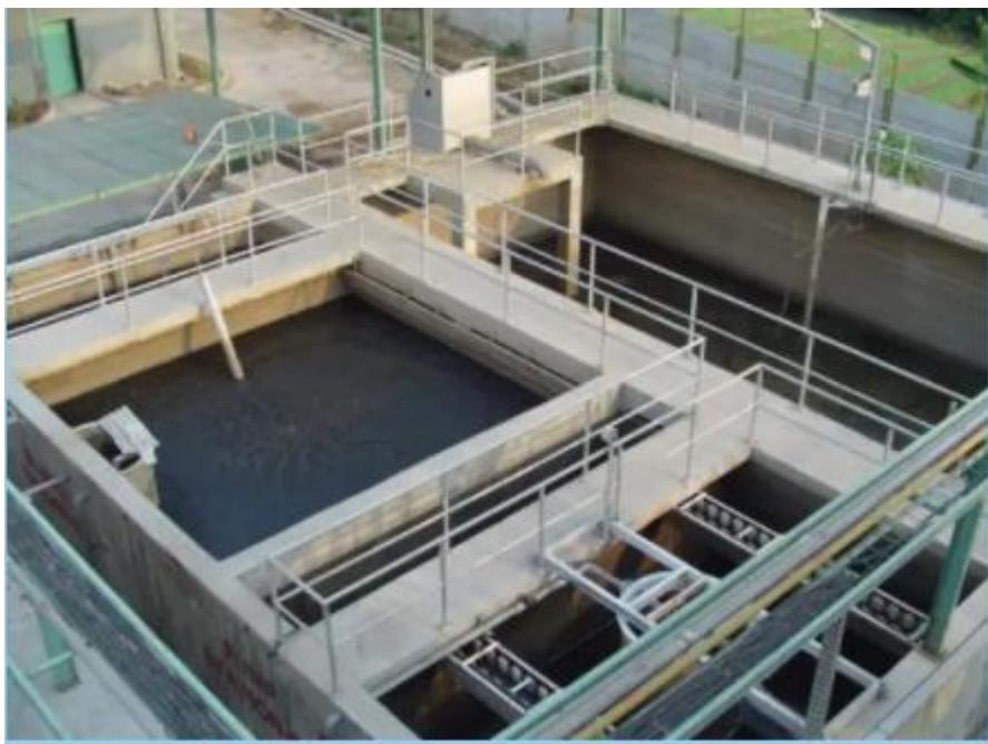
Gambar 7. Tangki pencampuran dan sedimentasi awal sebelum limbah cair dimasukkan ke reaktor anaerobik
